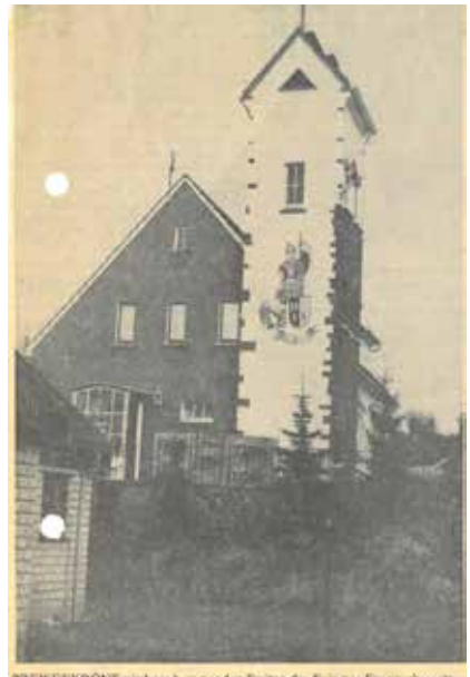
PREISGEKRÖNT wird am kommenden Freitag das Evinger Feuerwehrgerätehaus. Bei einem Fassadenwettbewerb, der von einer großen Farbenfirma in Zusammenarbeit mit einem Malergroßhandel in Lennebstadt ausgeschrieben wurde, gewann die Malerfirma Herbert Gerdes (Evingen) für die Gestaltung des Hauses einen Preis. Auch andere von Malermeister Gerdes gestaltete Fassaden (etwa in Herlesloh oder Elversinggen) werden am Freitagabend in der Lennebstädter Sauglamphalle präsentiert. AK-Peter Bender
