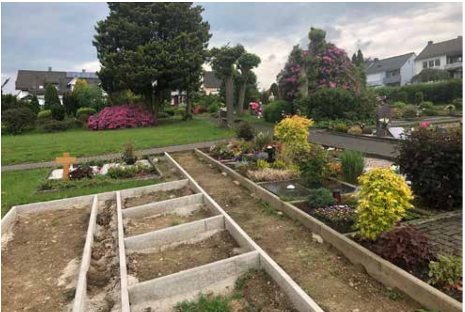
Bau der neuen Urnenwahlgräber
